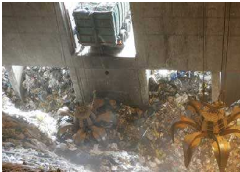
Affaldssiloen med de to kranrabber, set fra kontrolrummet
