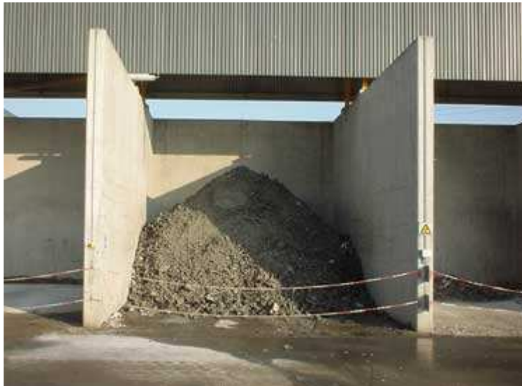
Slaggesilo på slaggepladsen
